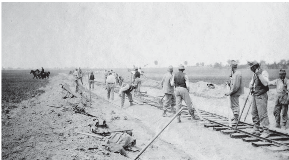
Lavoratori militari addetti alla costruzione di una linea ferroviaria in Galizia. MSIG, AF, 301/142.
