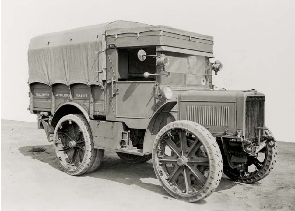
Fig. 1- Trattrice Breda 32 da poco consegnata al reparto di assegnazione, il cui nome purtroppo non è ben leggibile sulla fiancata. L'immagine consente di cogliere molto bene il disegno della cabina e del cofano motore, nonché le ruote con semipneumatici che dà al mezzo un aspetto piuttosto antiquato, ben diverso dai mezzi che seguiranno solo pochi anni dopo, impressione confermata anche dal clacson a trombetta e dai due fari ad olio posizionati ai lati della cabina. Ciononostante, il mezzo assolse molto bene il compito per cui era stato concepito e costituì un'ottima base per lo sviluppo di diverse varianti e di versioni più moderne.
