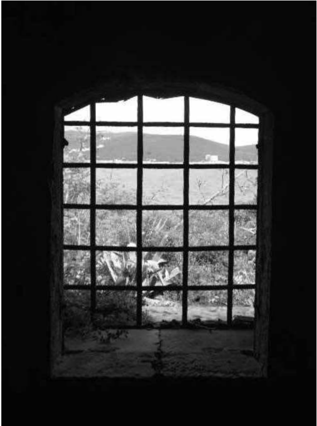
Fig. 5 - Forte Mamula, feritoia cannoniera chiusa con sbarre metalliche.
