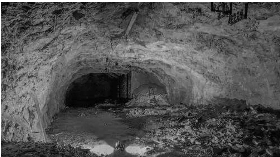
Fig. 1 - Vista interna dello stato attuale del rifugio Alla Busa di via Grazioli.
