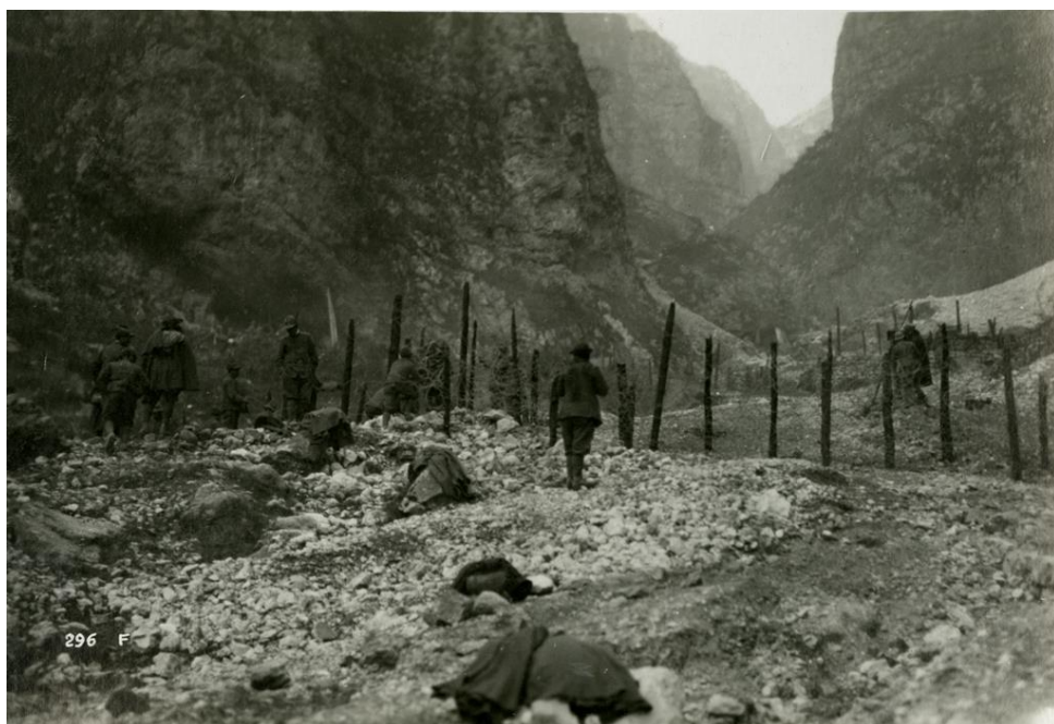
Val Frenzela. Riparazione della linea di sbarramento (MSIG, AF, Fondo Maurizio Rava , 2/494).
