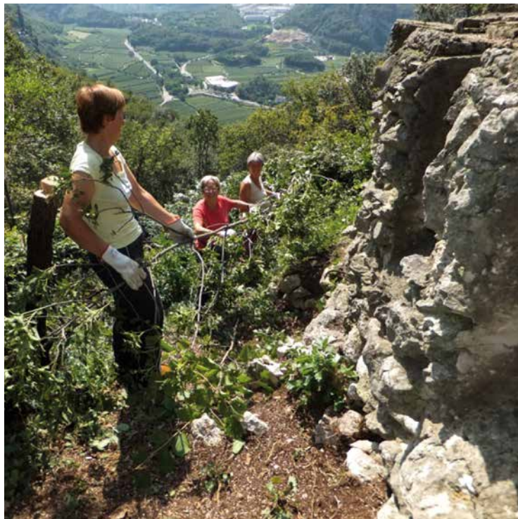
Lavori sul monte Corno [Un Territorio Due Fronti]
