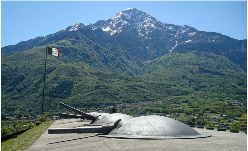
Fig. 5 - Forte Montecchio Nord di Colico (LC). Il sistema dell'armamento in copertura. (foto dell'A., maggio 2016).
