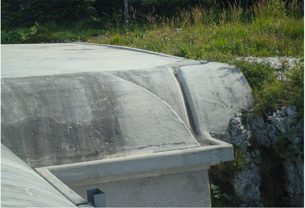
Fig. 12 - Forte Campolongo (VI). Particolare del canale di gronda ricavato nella massa di calcestruzzo. (foto dell'A., settembre 2016).
