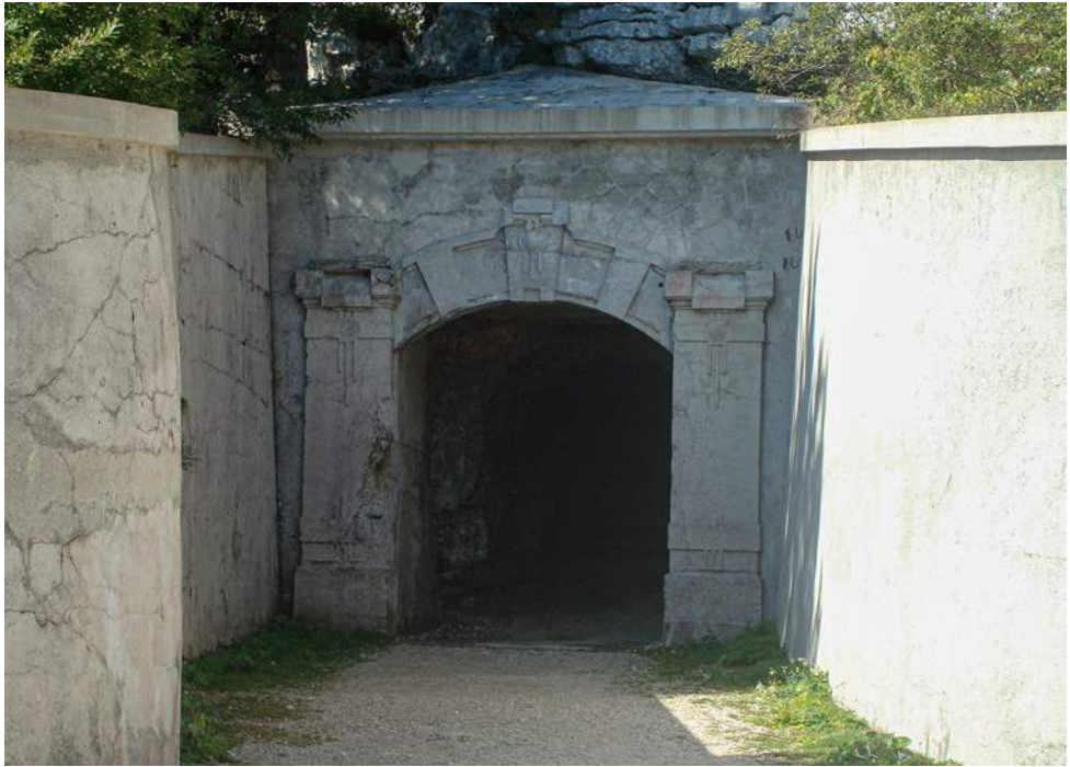
Fig. 10 - Forte Campolongo (VI). Portale di accesso alla galleria. (foto dell'A., settembre 2016).
