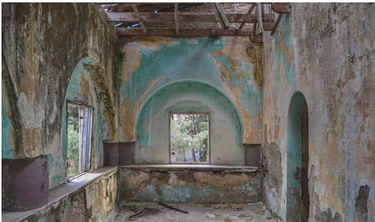
Lo stato attuale di quella che un tempo era la terrazza annessa alla residenza del sindaco di Campochiaro. L'ambiente, reso chiuso durante la trasformazione del centro rurale a sanatorio, è risultato particolarmente importante per comprendere e datare diverse dinamiche di trasformazione. Ottobre 2018 [foto Andrea Zaniboni].
