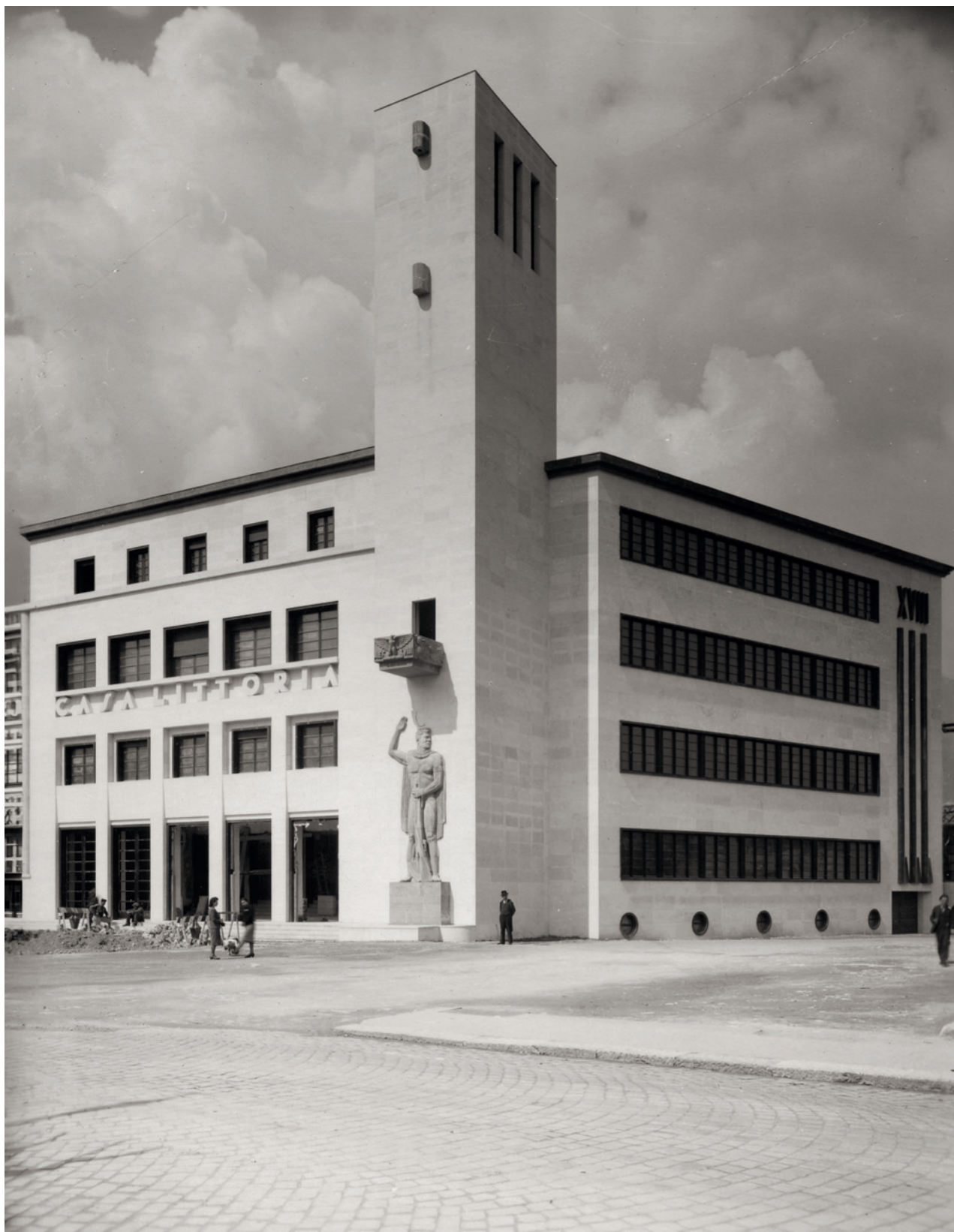
Fig. 6 - La casa del fascio di Trento [Archivio fotografico provinciale, fondo fratelli Pedrotti , F_196295].
